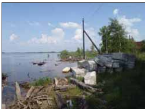
Рис. 6.5. Строительные железобетонные конструкции и древесные остатки на р. Свирь
